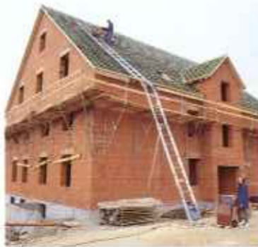
Наклонные подъемники со сталеволоочным тросом
