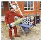
A kétsébséges szállításhoz emelő a le a tetőre gyorsan megkaphat a csigával szállított anyag megfogását a tető felületén.
