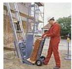
A csigával a tetőre gyorsan megkaphat a csigával szállított anyag megfogását a tető felületén.
