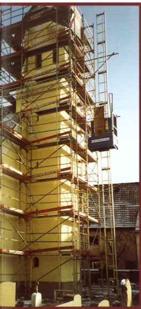
Die Verbindung der Leiterteile erfolgt über einen integrierten Schnellverschluß, der gleichzeitig als Überfahrerschutz und Endschal- teranfahrblech dient.
