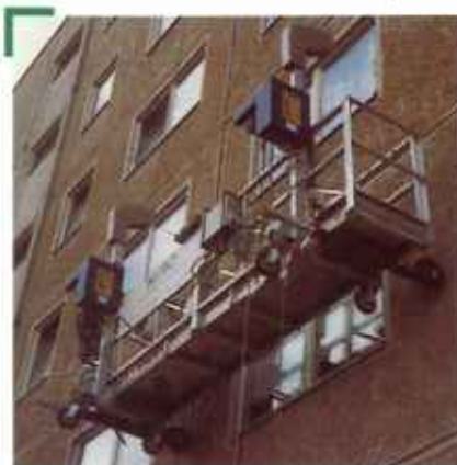
При ремонте бетонных фасадов подвесные рабочие платформы эффективнее других подъемных механизмов благодаря существенно меньшему времени монтажа и низким эксплуатационным расходам.
