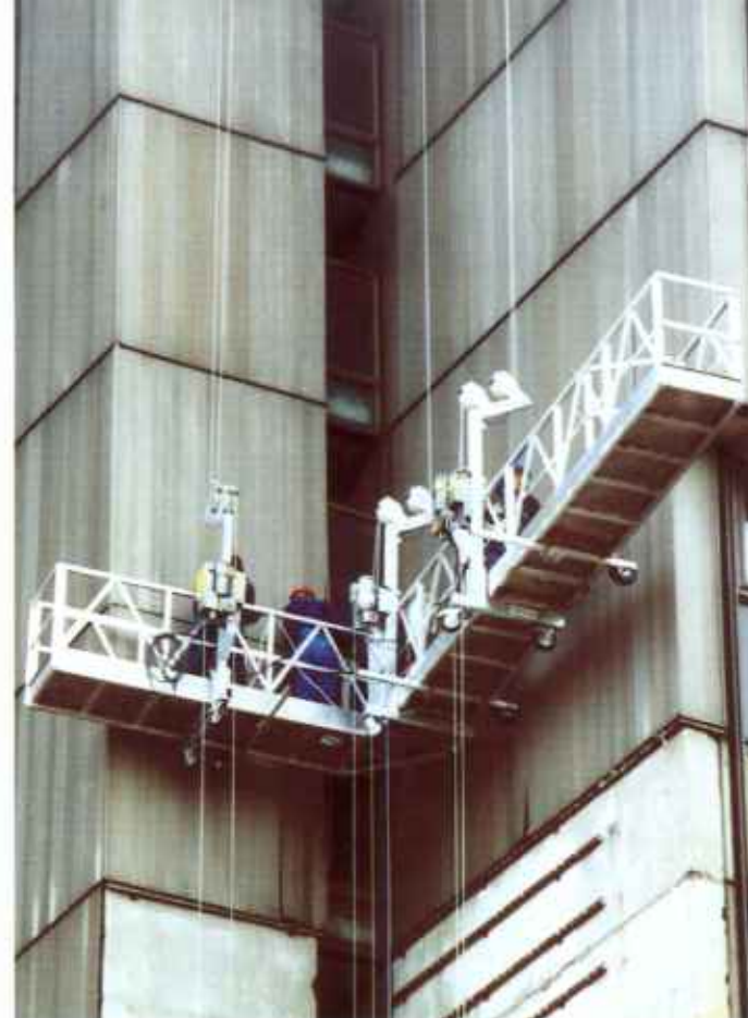
Специальные устройства управления позволяют одновременно использовать до 4 приводов, что даёт возможность собирать более крупные платформы.
