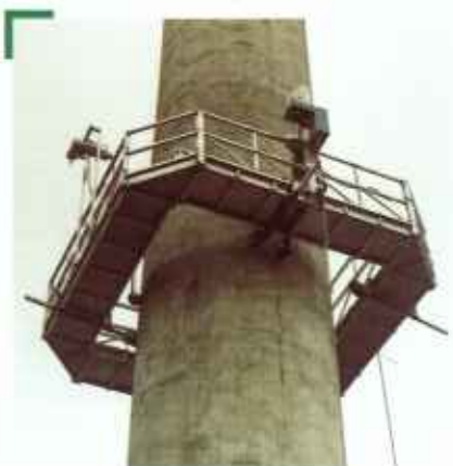
Благодаря использованию угловых секций платформа легко адаптируется к форме здания.
