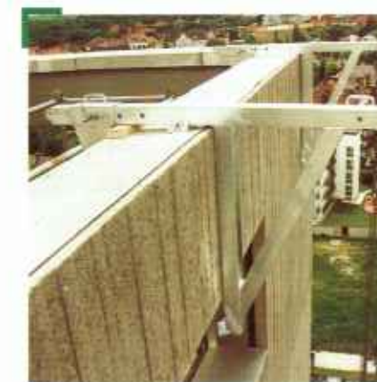
В качестве альтернативы консоли GEDA предлагает параллельное устройство крепления, которое очень эффективно, если параллель достаточно прочен, чтобы выдержать нагрузку.
