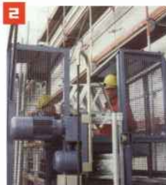
2 Einfache und schnelle Montage vom Inneren des Fahrkorbes; Montagetunnel öffnen, Mastelement einhängen, hochklappen, die unverlierbaren Schrauben (M16) mit selbstsichernden Muttern festziehen – fertig.
