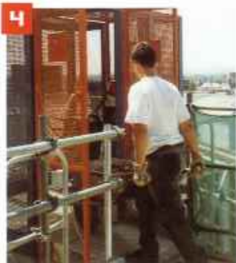
4 Zur Ladestellensicherung werden 1,1 m hohe, verzinkte Etagentüren montiert. Diese sind bereits komplett mit Zuleitung zur Reihenschaltung und integrierter Steuerung ausgestattet.
