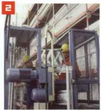
2 Einfache und schnelle Montage vom Inneren des Fahrkorbes: Montagetunnel öffnen, Mastelement einhängen, hochklappen, die unverlierbaren Schrauben (M16) mit selbstsichernden Muttern festziehen – fertig.
