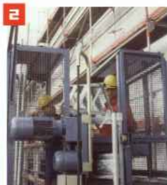
2 Einfache und schnelle Montage vom Inneren des Fahrkorbes: Montageturm öffnen, Mastelement einhängen, hochklappen, die unverlierbaren Schrauben (M16) mit selbstsichernden Muttern festziehen – fertig.
