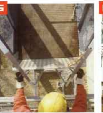
5 Beim Erreichen der Ladestelle wird die Kabinentür selbsttätig entriegelt. Zum Übertritt klappt beim Öffnen automatisch eine Rampe mit Seitenschutz auf.
